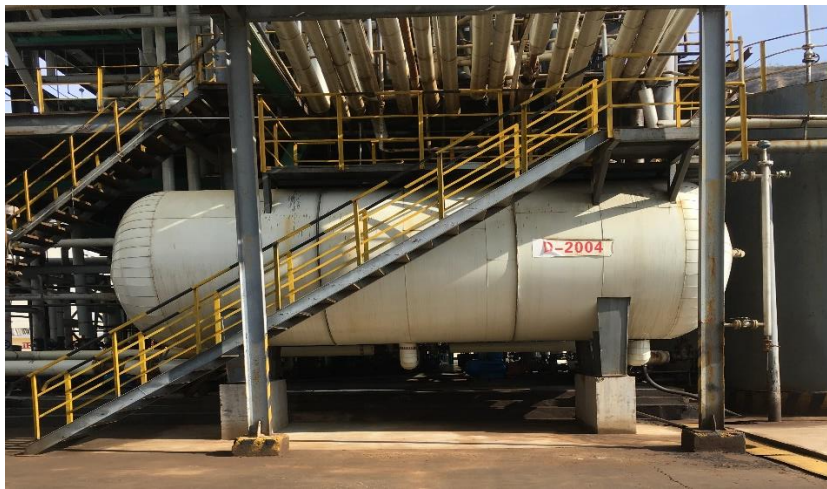
照片 7 萃取液储罐
